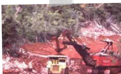
# ERDARBEITEN AN EINER BAUXIT-MINE IN JAMAICA ©pixabay/PaulMorris
